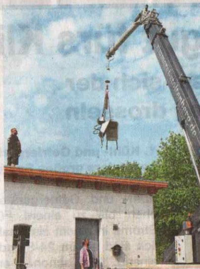
15 Tonnen Granulat werden auf dem neuen Dach des Windmühlen-Magazins verteilt.
